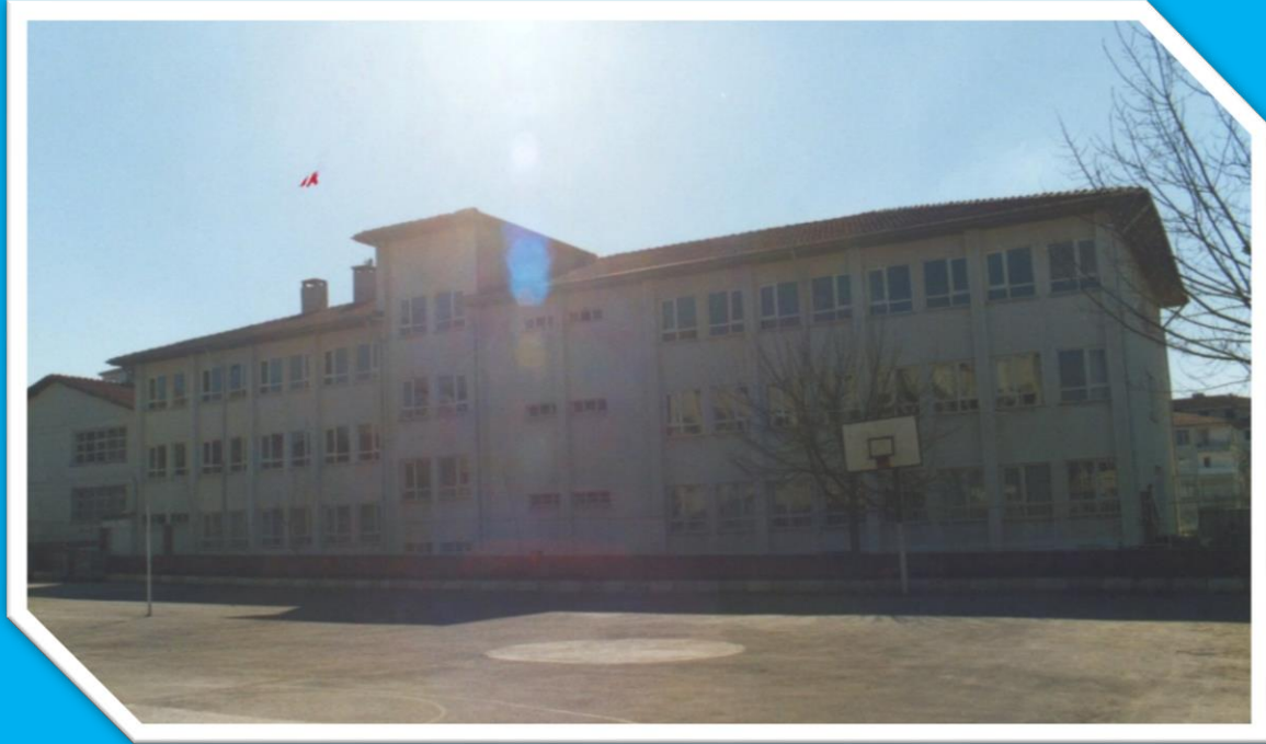
Resim-2: Okulumuzun yapımından. Şimdi ki Hasan Şadoğlu Lisesi bahçesinden.
